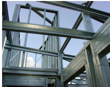
Figura 02 – Construção de uma residência em “ Light Steel Framing ”.
