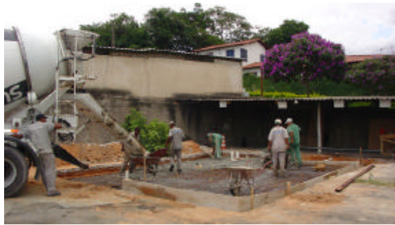
Figura 07 – Fundação do tipo Radier.
