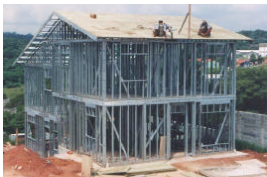
Figura 03 – Montagem da estrutura metálica – “ Steel Frame ”.
