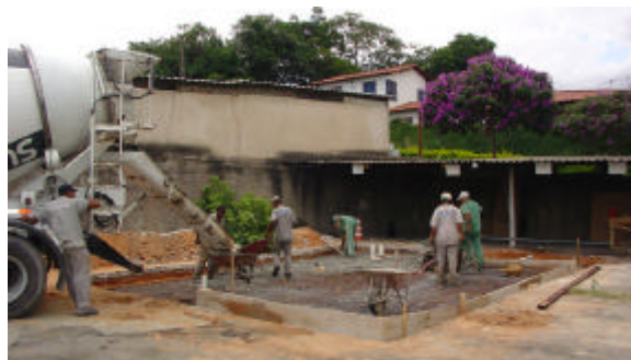
Figura 07 – Fundação do tipo Radier.
