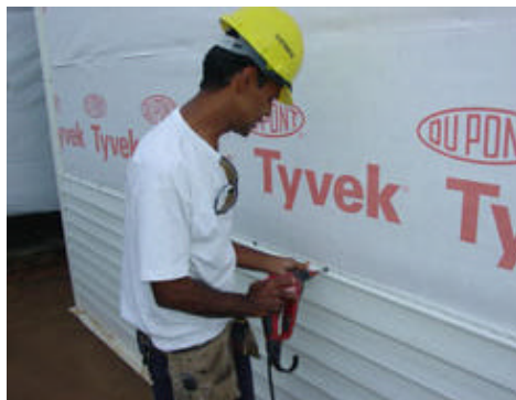
Figura 13 – Fechamento externo em “ Siding Vinílico ”.
